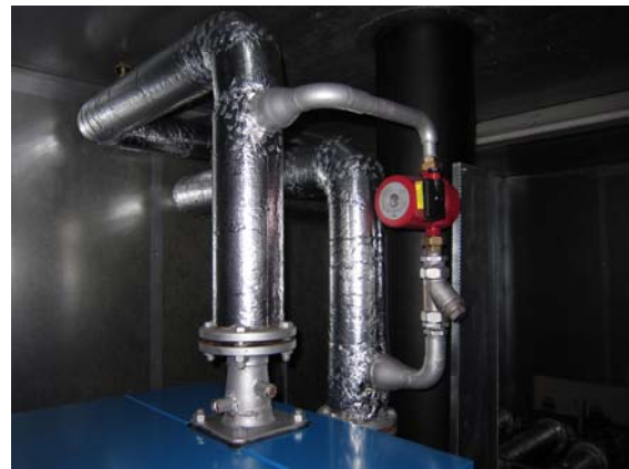
Tur- returrør med shuntpumpe
